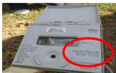
Fig. 05 – hidrômetro ultrassônico
